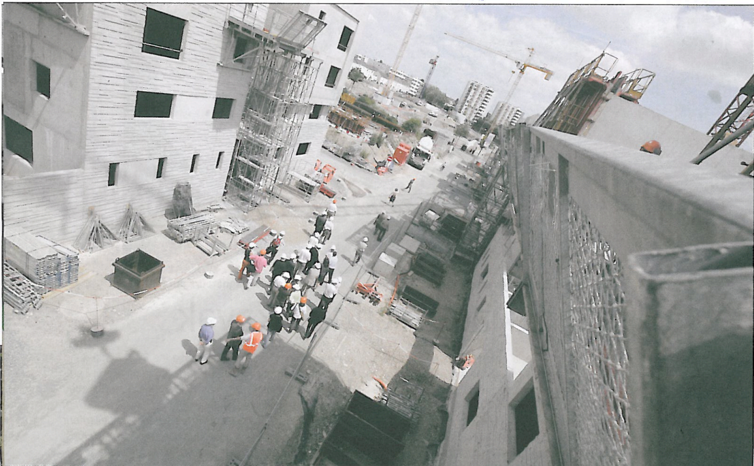
La nouvelle rue Le Gouz prend forme avec les nouveaux immeubles d'Angers Habitat.
