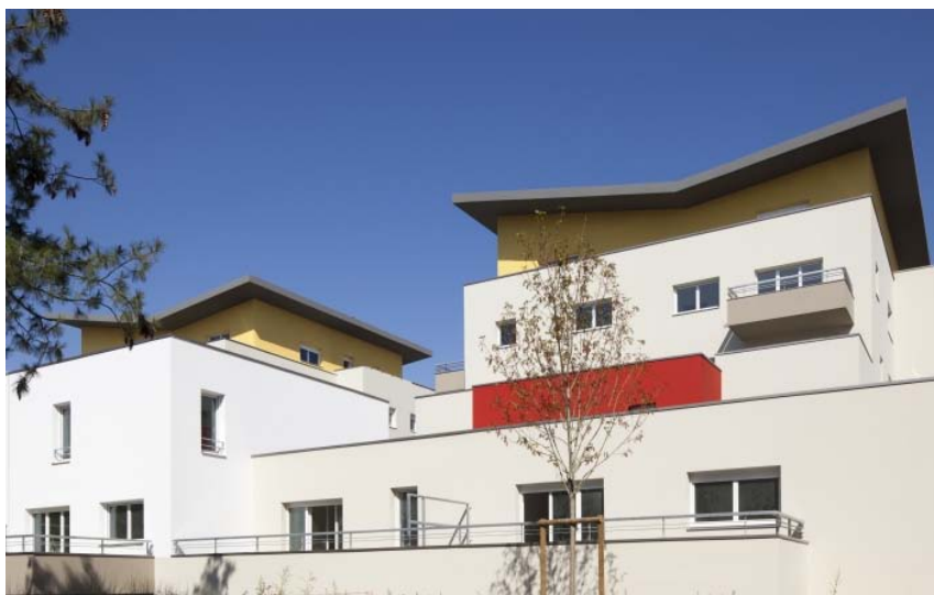
Logements Sociaux - Angers- ZAC du Grand Pigeon - Studio Bellecour - N.Borel
