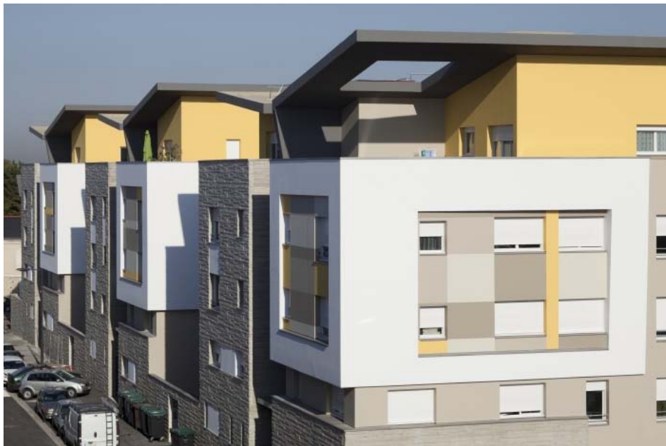
Logements Sociaux - Angers- ZAC du Grand Pigeon - Studio Bellecour - N.Borel
