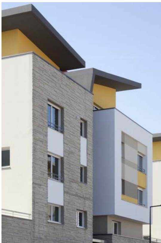
Logements Sociaux - Angers- ZAC du Grand Pigeon - Studio Bellecour - N.Borel
